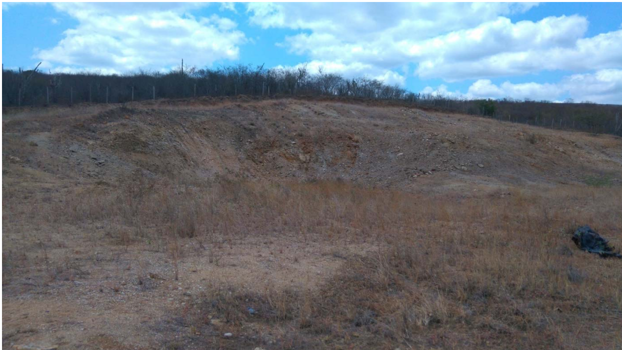
Vista do talude após terraplanagem
