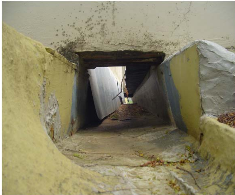
Figura 22 – Vista da entrada da calha
