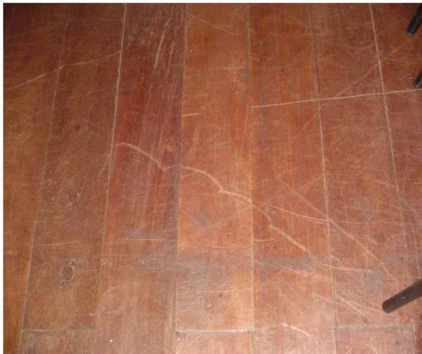
Figura 06 – Piso de Madeira
