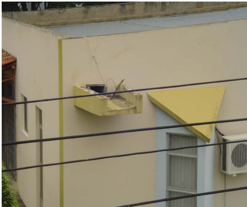
Figura 02 – Detalhe da Construção
