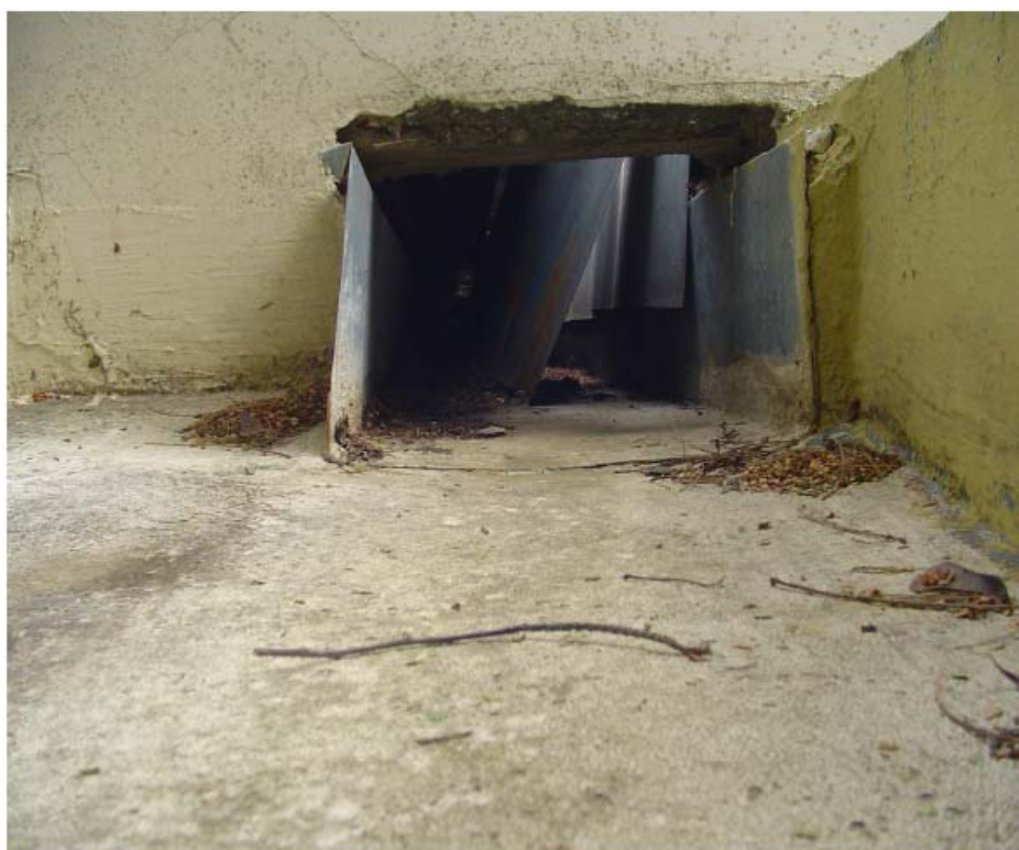
Figura 20 – Vista da calha
