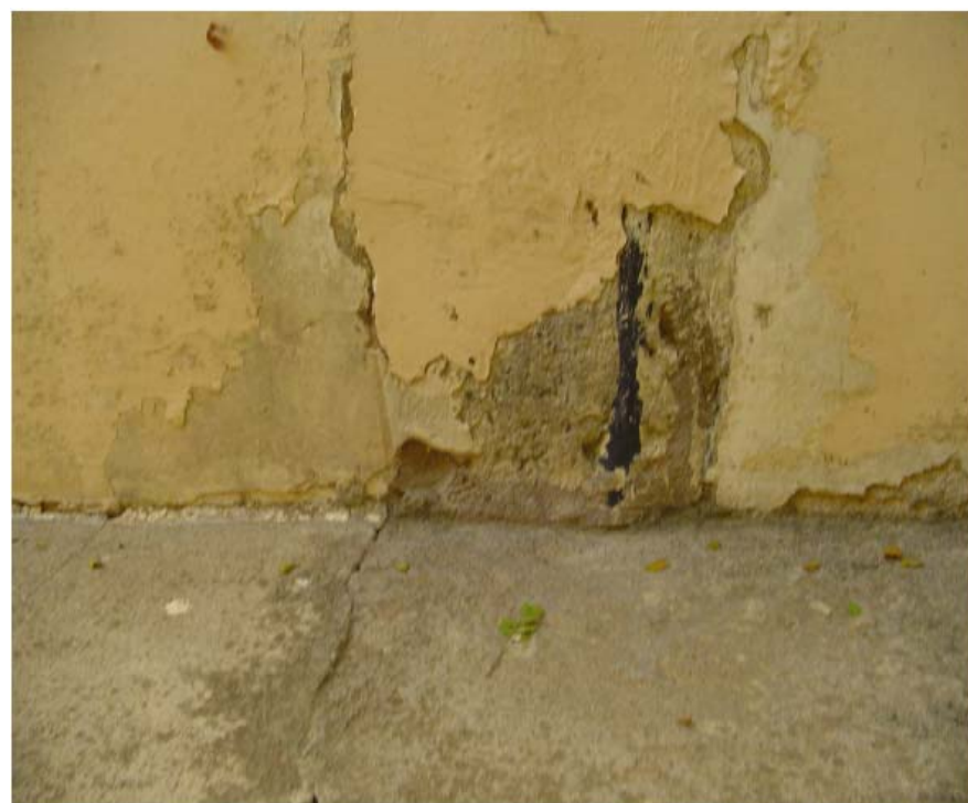
Figura 26 – Ferragem aparente no pé do pilar
