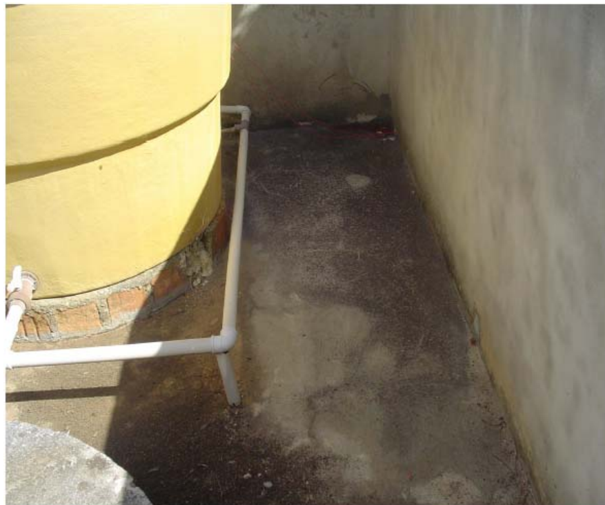
Figura 29 – Vista da laje da cozinha
