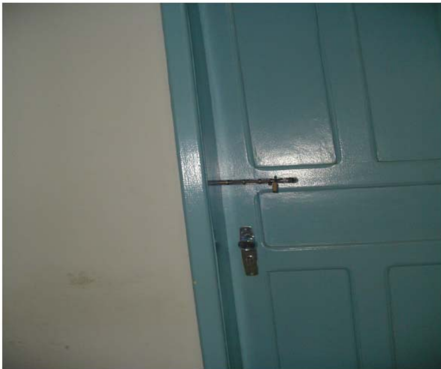
Figura 17 – Porta de saída de emergência
