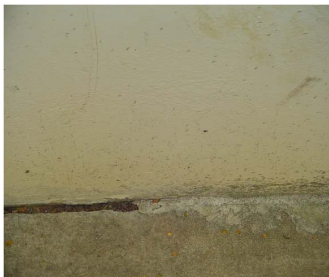
Figura 10 – Detalhe do bloco
